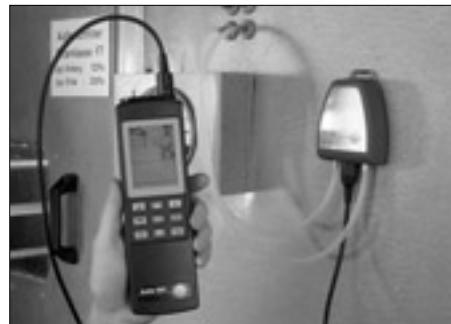
外付け圧力プローブを接続して、フィルタの差圧計測
