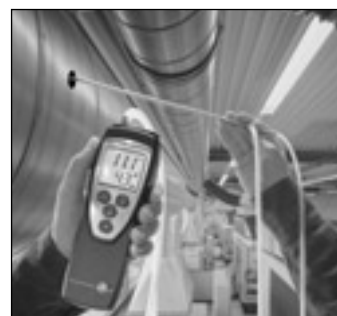
ダクト内の風速チェック
