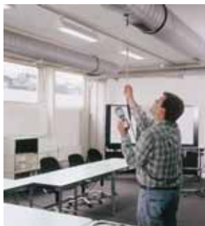
高所の風速・風量計測
