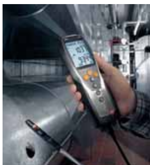
ダクトの内側や排出口での風速・風量計測
