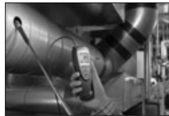
ダクト内の風速計測
