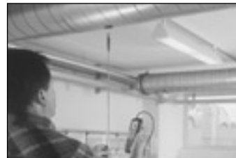
排出口の風速計測
