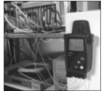
コンピュータシステムの温度を記録
